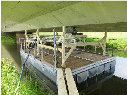
**Bild 6: Untersuchung einer Spannbetonbrücke mit Hilfe einer schwimmenden Plattform.**
