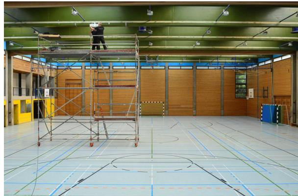
**Bild 7: Untersuchung von Spannbetonbindern einer Sporthalle.**
