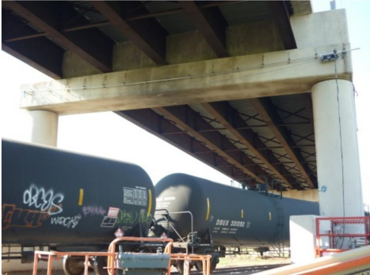
**Bild 10: Untersuchung von Brückenträgern mit parabolisch verlaufenden Spanngliedern.**
